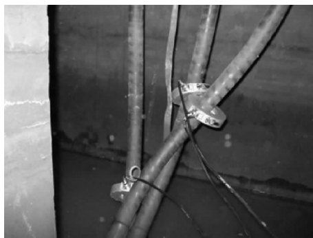
图6 高频电流传感器套于三相电缆
